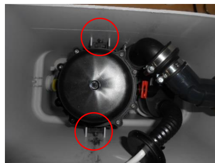
③ ガイドレール内に防振ゴムが正しくセットされていることを確認します。
