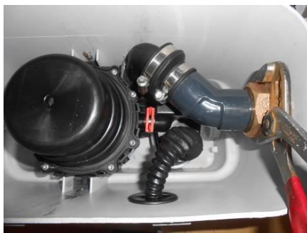
⑤ 袋ナットをウォーターブライヤー等で適切に締め付けます。
