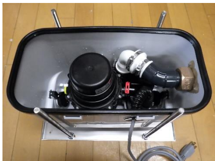
② フランジ枠、および本体蓋を外します。
