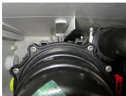
④ 写真のように、固定ガイド1をガイドレールAの左側に添わせませす。
