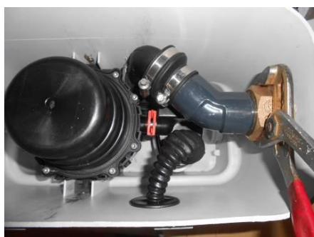
③ ウォータープライヤー等で袋ナットを外します。
